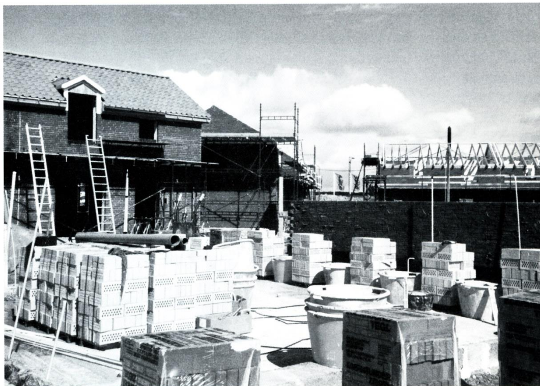
Byggeri af "Hollænderparken", Skrillinge, 1987.
