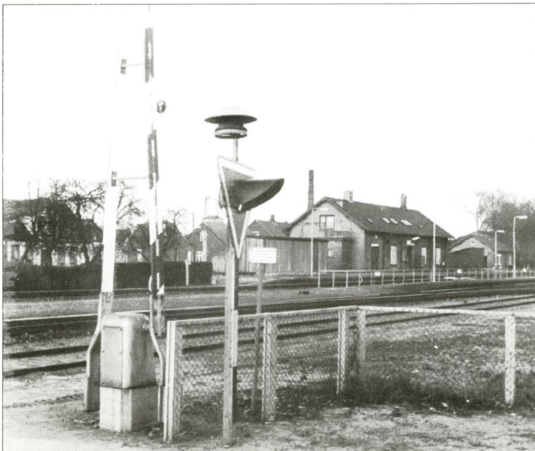
Baneoverskæring ved stationsbygning
